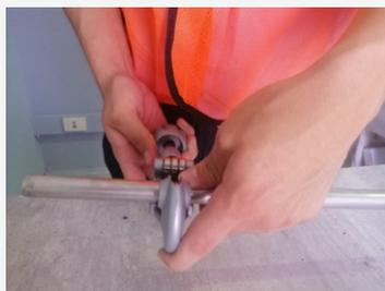
1. Corte el tubo con herramientas especiales que no dejen rebordes externos que puedan dañar los o-ring y tener fugas.
