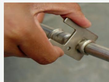
6. Verifique el sellado con el calibre. Finaliza la instalación, compruebe la inexistencia de fugas mediante las pruebas hidráulicas.
