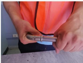
2. Inserte el tubo en la conexión hasta sentir un tope. De ser necesario lubrique el o-ring con jabonosa. No utilice grasa ni aceites.
