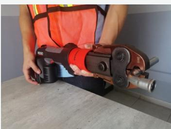
5. Verificando que no hubo desplazamiento del tubo y conexión (marca del punto 3) cerrar la válvula de alivio y accionar la herramienta hidráulica hasta unir los extremos de la garra (mordaza), sin dejar espacio entre los mismos.
